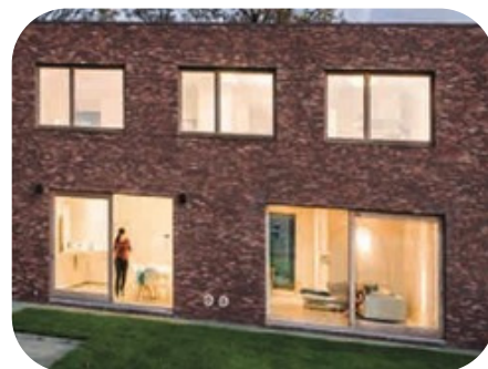
Maison sans unité extérieure
